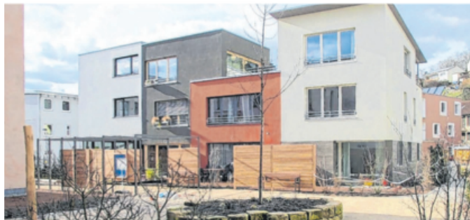
Blick ins Quartier Alte Weberei in Tübingen. Foto: Ipondh Architekten
